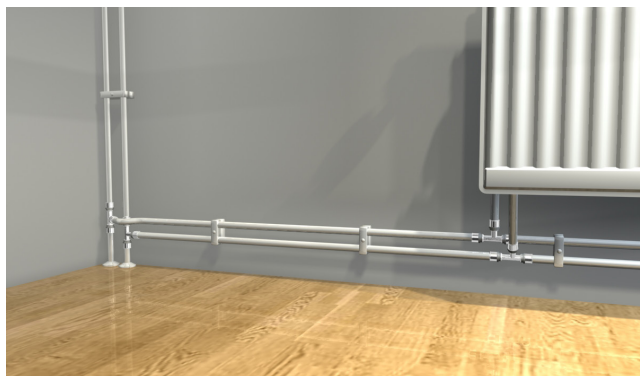
Exempel klamring med synligt montage.
